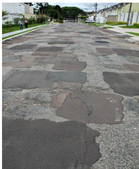
Imagen 1: Calle con remiendos que pueden generar arrancamientos en la banda de rodadura.
